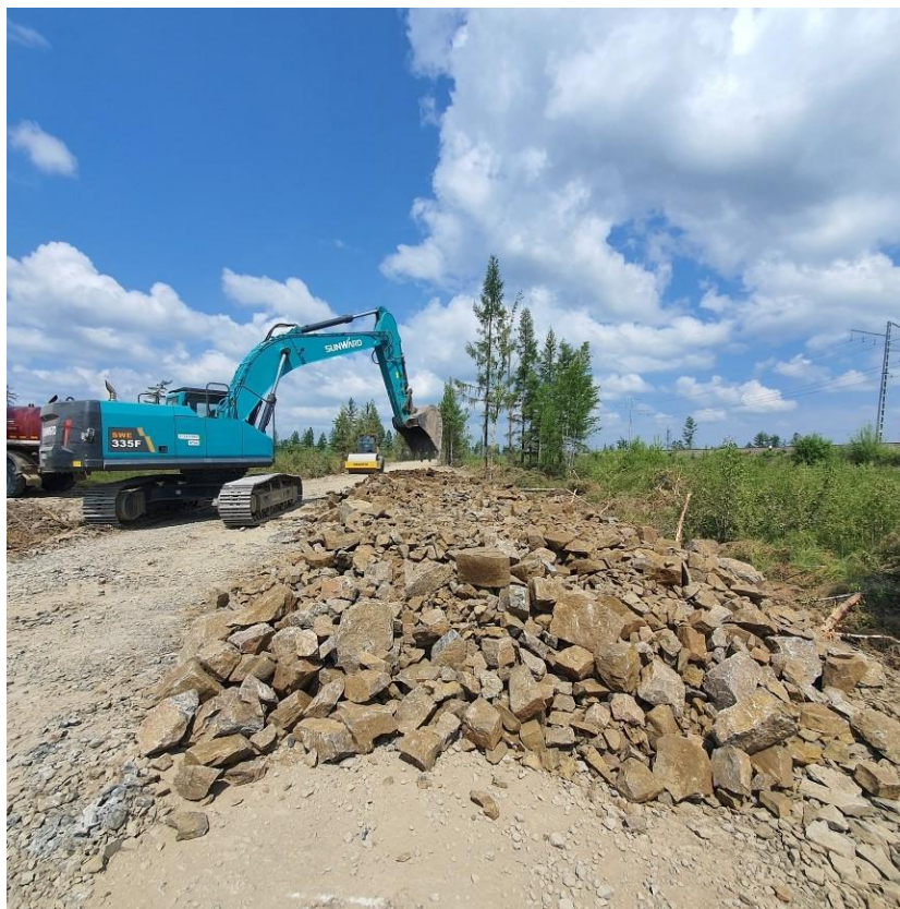
Рисунок 1 – Устройство насыпи из скального грунта
